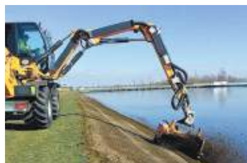
bema 25 med ugressbørste, montering gravemaskin (spesiell konstruksjon)
